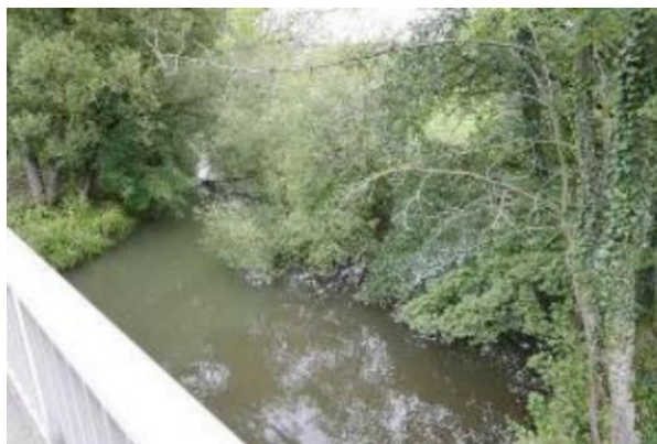
Die die „Koblenzer Straße“ unterfließende Wied
